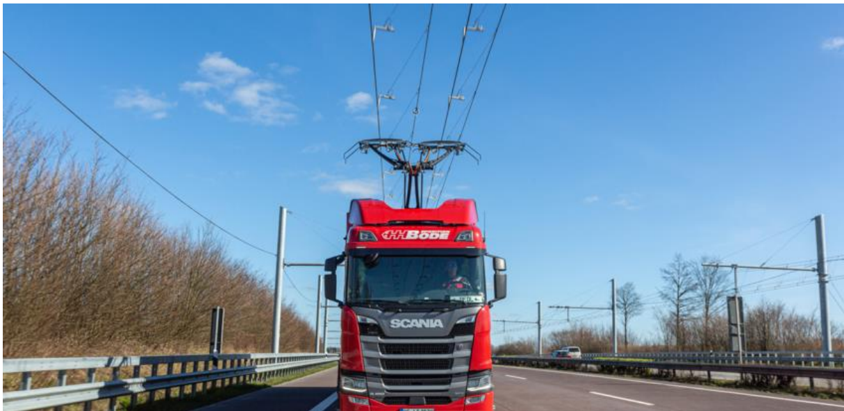
Die fünf Kilometer lange E-Highway-Strecke auf der A1 zwischen der Anschlussstelle Reinfeld und dem Autobahnkreuz Lübeck wird von Siemens Mobility betrieben ©Siemens 01.04.2021 (mh)
