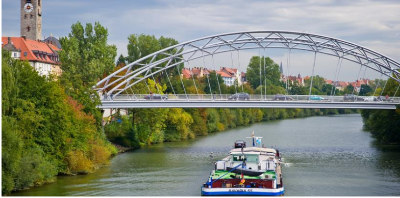
Die Schleusensperrung bei Bamberg ist wieder aufgehoben worden ©David Ebener/dpa/picture-alliance
