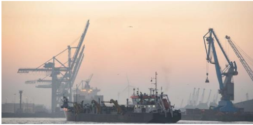
Diese Woche beginnen die Bauarbeiten für die Elbvertiefung ©Daniel Reinhardt/dpa/picture-alliance
